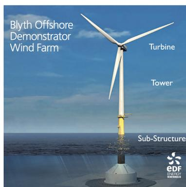
FIGURE 1 – Composants d'une éolienne offshore
